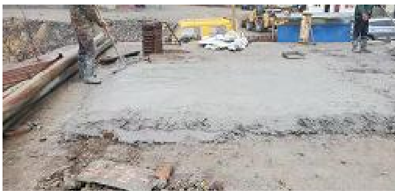
图 3-2 废弃井筒正在封闭图
